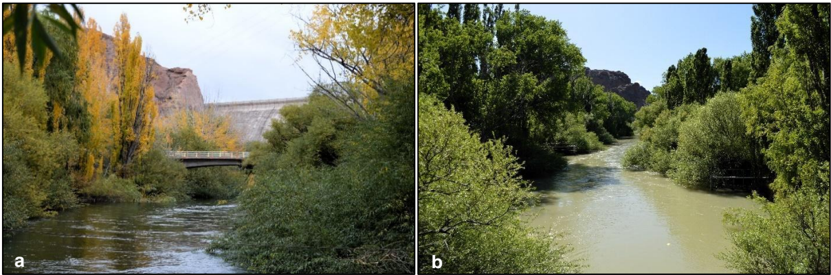
Figura 2. Sitio I: Puente del Dique Florentino Ameghino (DFA). (a) Puente; (b) vista desde el puente.
