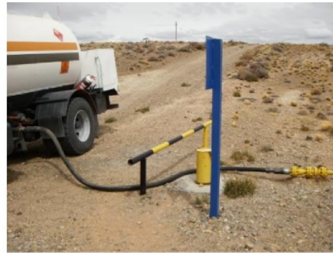
Extracción del líquido condensado por parte de uno de los contratistas de YPF S.A
